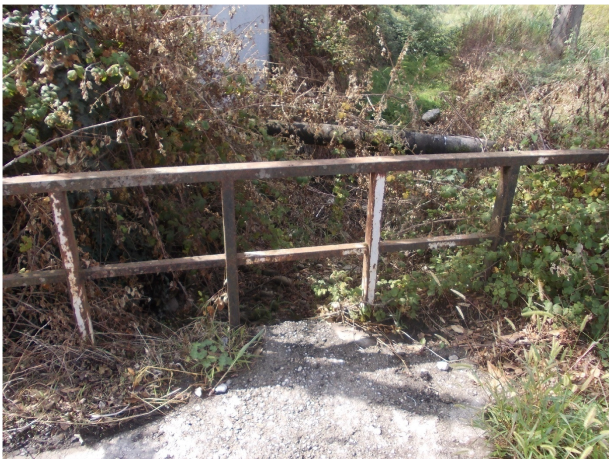
Foto 10 – vista di attraversamento stradale
