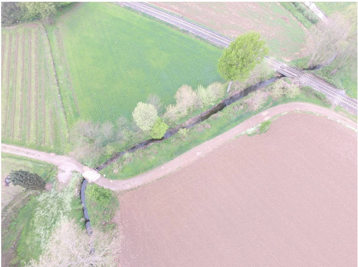
Foto 6 - immagine del torrente ripresa da drone – attraversamento ferroviario e stradale
