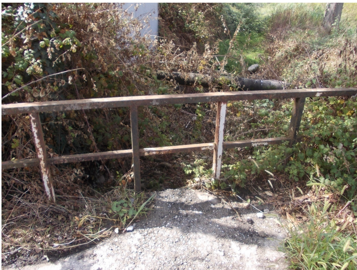
Foto 10 – vista di attraversamento stradale
